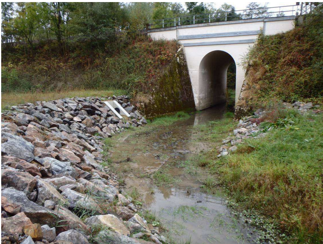
Pohled na propustek pod železniční tratí s korytem Zádolského potoka. Propustek není opatřen pochozími bermami.
