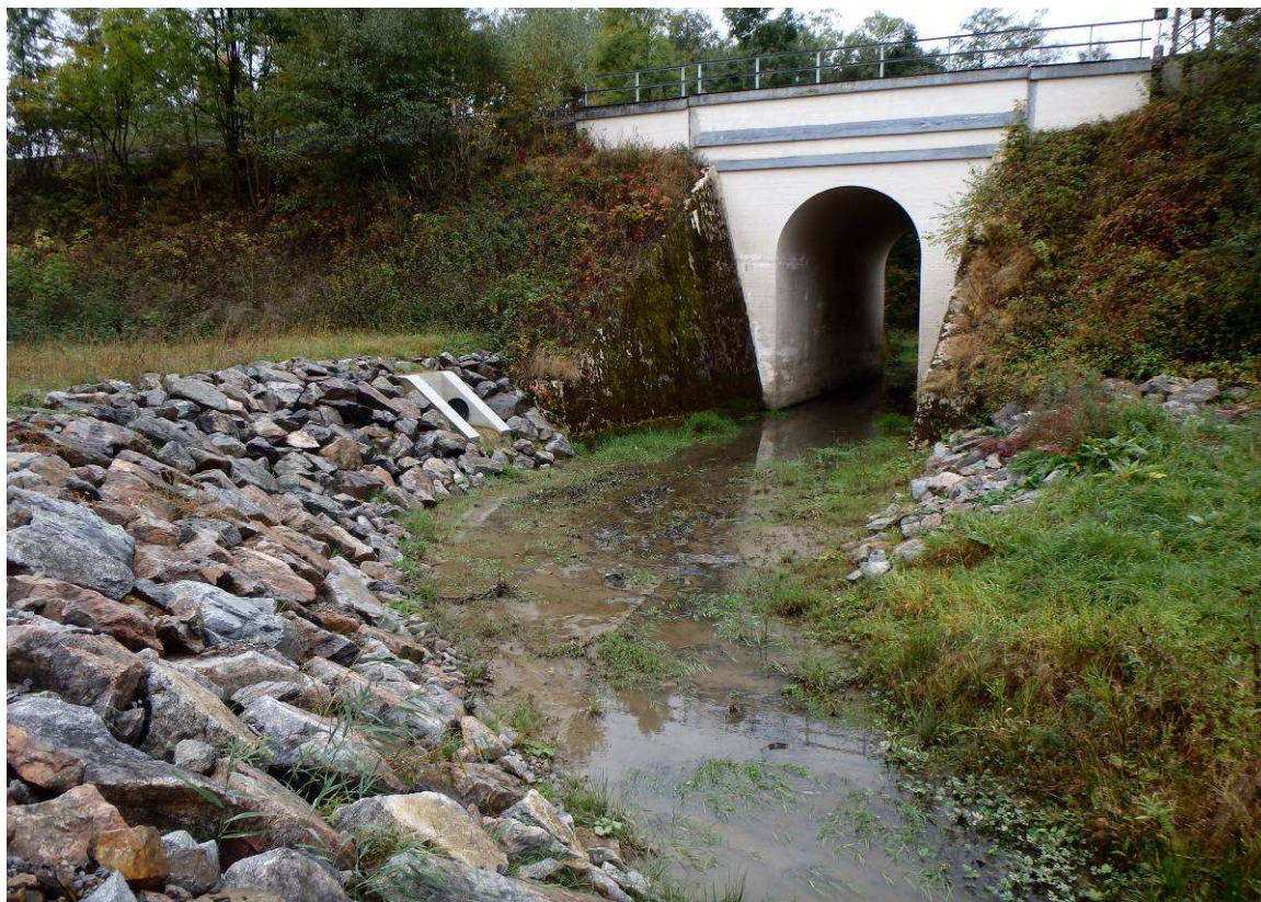
Průchod Zádolského potoka pod tratí. Je vidět absenci pochozích berm a zához lomovým kamenem až ke křídům mostu.
